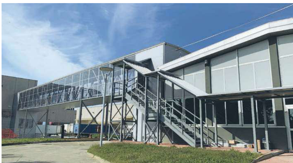
TUNNEL SOPEPO PER TRASPORTO PALLET
